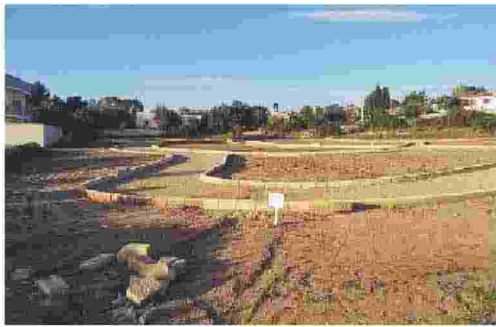
LAVORI IN CORSO L'area al centro del progetto
