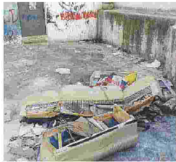
IL DEGRADO Il «cantiere» un anno fa
