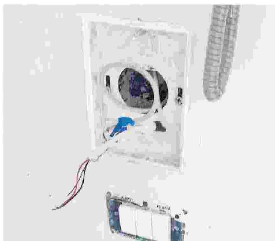
Danni. L'impianto di videosorveglianza distrutto
