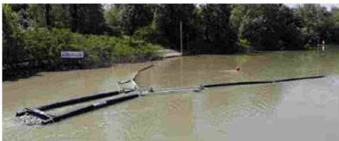
Nella foto: Sistema recupero rifiuti galleggianti della “Castalia Operations s.r.l.” installato sul fiume Po.
