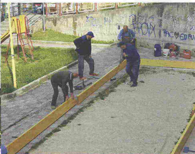
A sinistra: i volontari dell'Auser all'opera per sistemare il "Teatro a metà" a Lauria . In basso: il restauro della fontana di un parco a Potenza . Qui sotto: nuova vita per il campo da bocce a Grassano
