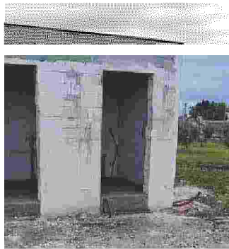
Il cantiere «visitato» dai ladri
