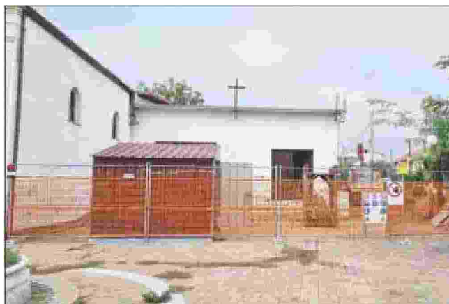
Il cantiere per la realizzazione del centro di aggregazione
