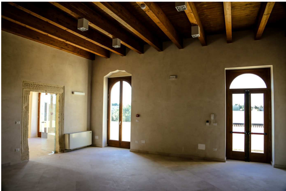
vista ambiente pluriuso zona ingresso, piano primo corpo Masseria
