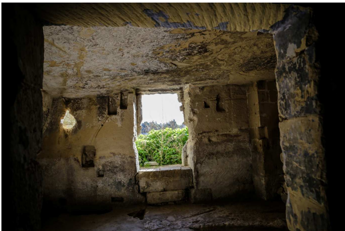
altro vano ipogeo
