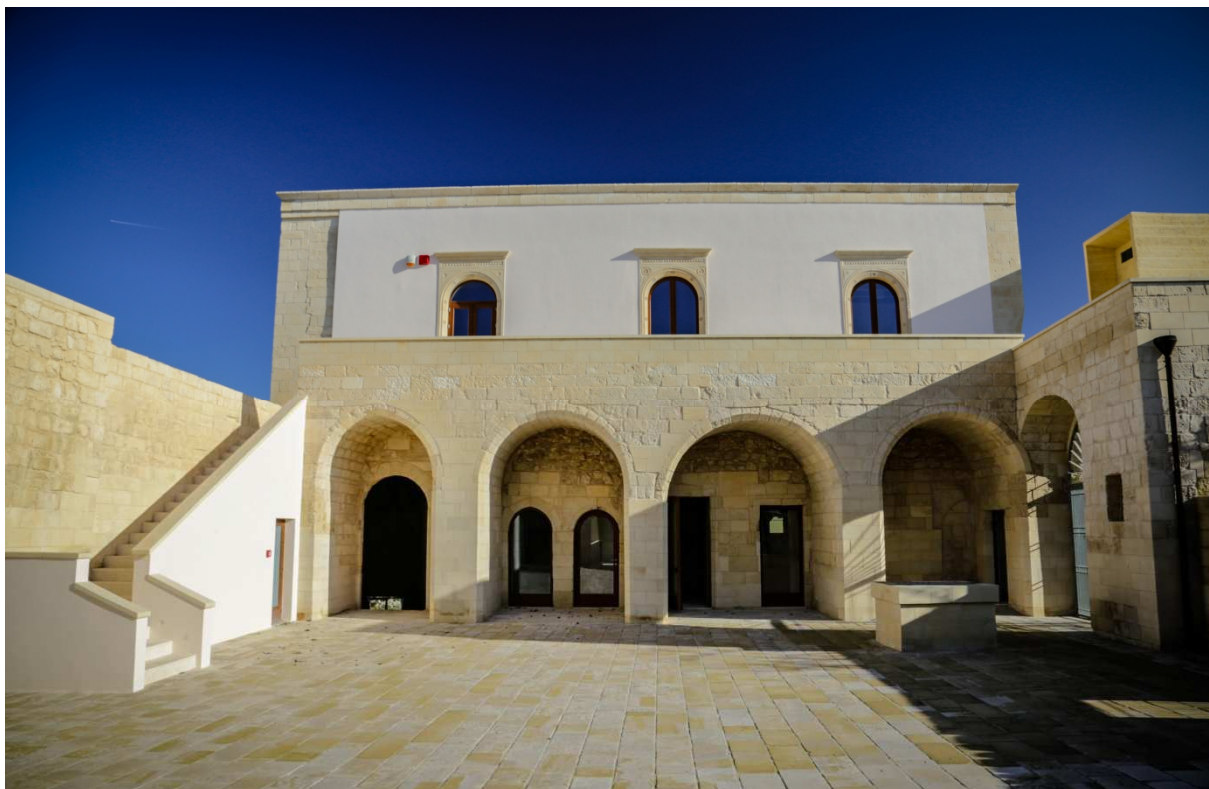
prospetto interno corpo Masseria
