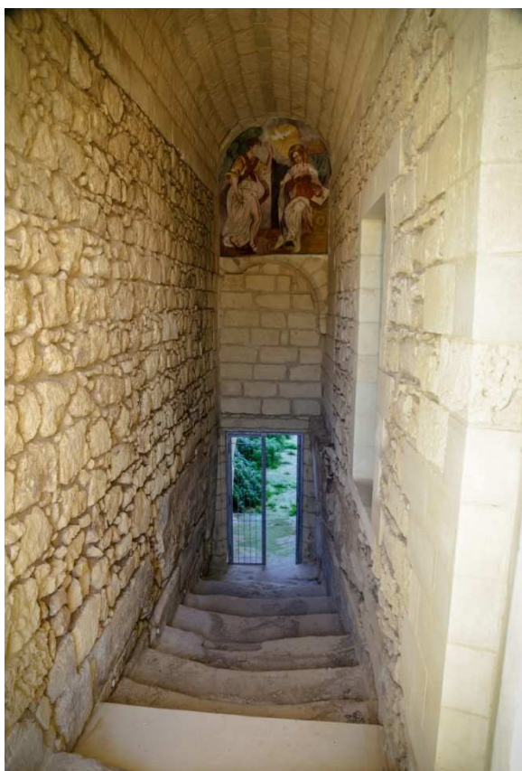
vista della scala che dalla corte conduce al Ninfeo
