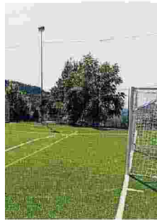
Il campo sportivo Via libera alla gestione esterna dell'impianto
