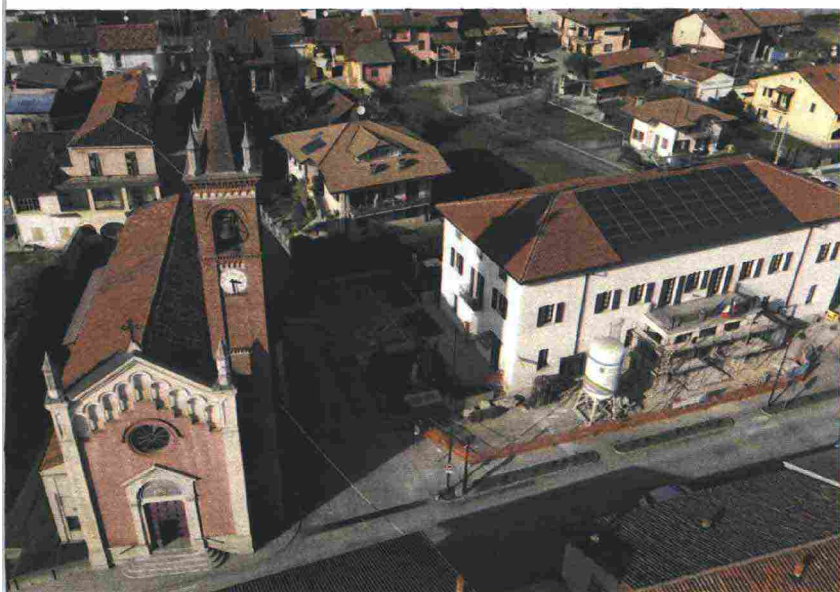
I pannelli solari sul tetto del municipio di Magliano Alpi (Cuneo)
