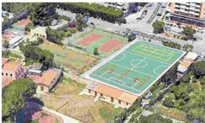
▲ Prima e dopo L'area nei pressi di via D'Amelio oggi e dopo i lavori
