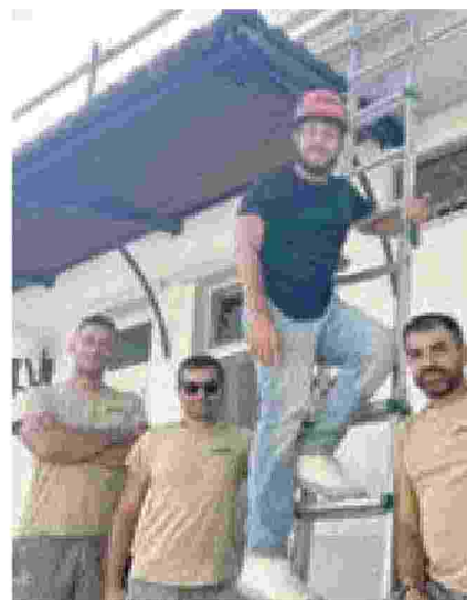
Antonio Miglio e alcuni operai al lavoro per l'installazione
