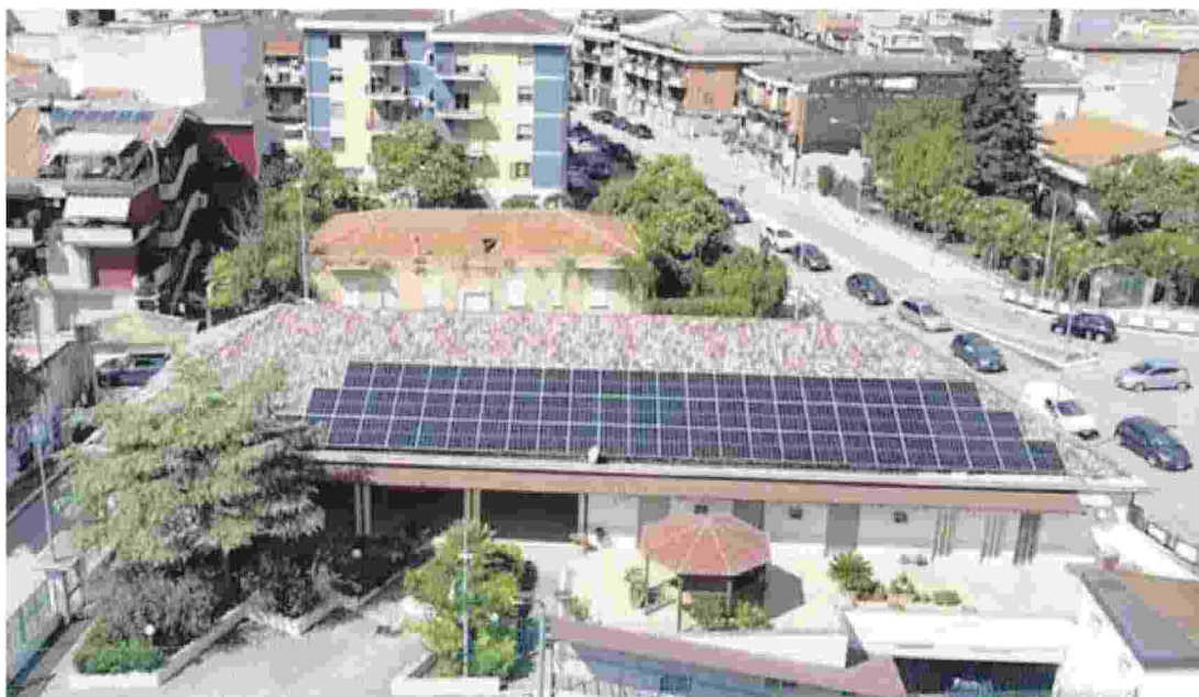
I pannelli montati sulla struttura sede della Caritas nell'ex istituto salesiano di San Severo
