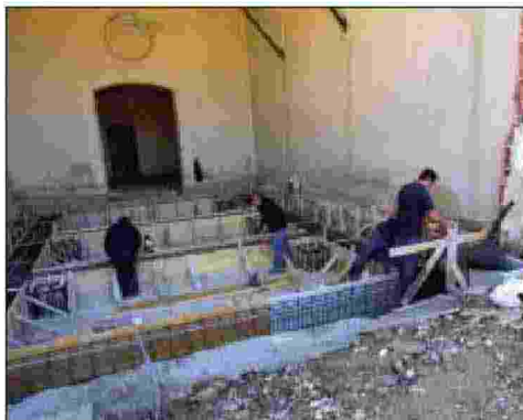
I lavori all'interno della struttura
